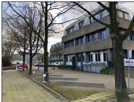
Foto rechts: achterzijde bestaande pand aan de Van Miereveltstraat.
